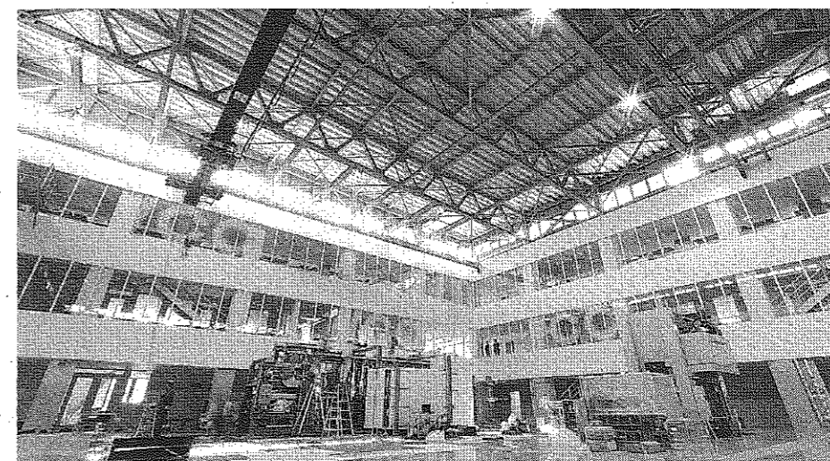
建設が進む革新複合材料研究開発センター(石川県白山市)
